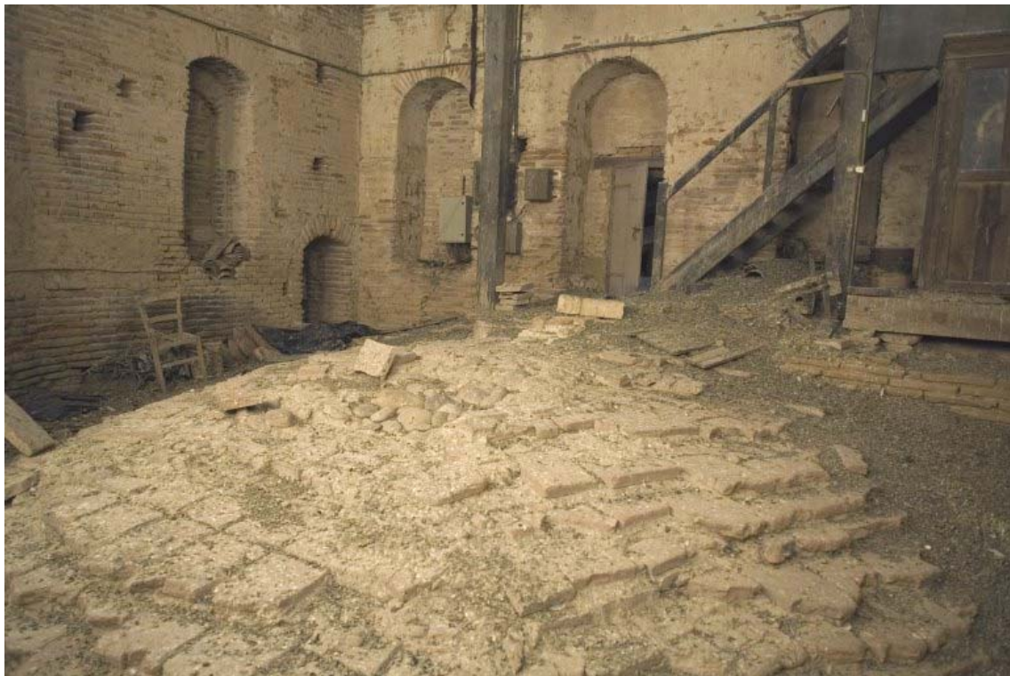
Figure 03 : Venerque, église Saint-Pierre, niveau de comble au-dessus de l'abside.
