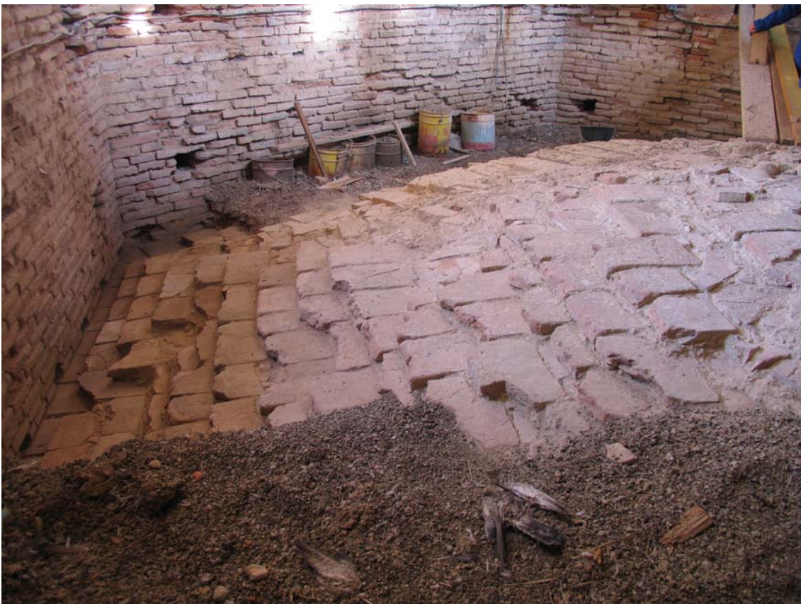
Figure 06 : Venerque, église Saint-Pierre, la couverture de l'abside.
