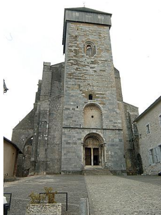
Fig. 2 Vue de la façade ouest et du clocher, cl. J.-F. Peiré
