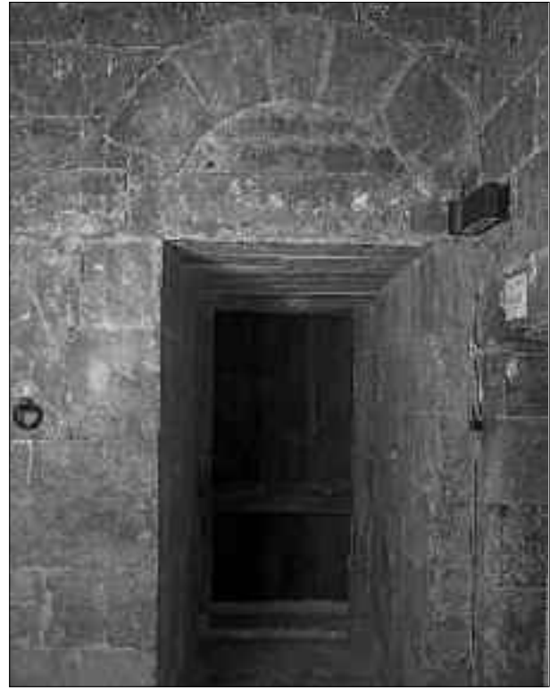
FIG. 8. VUE INTÉRIEURE DE LA PORTE DU 1 er ÉTAGE (mur nord). Cliché Pierre Plattier, Ville de Millau.
