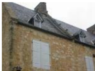
Le château : la couverture du corps de logis principal
