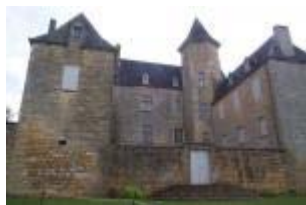
Le château : vue générale de la façade nord
