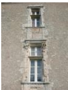
Le château de Couanac : fenêtres à traverse de l'élévation ouest de l'aile nord
