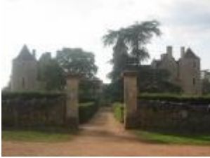
Le château de Couanac : vue générale depuis l'Est
