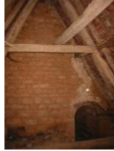
Le château de Couanac : comble de la chapelle bâti contre l'élévation nord de la tour
