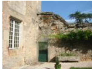
Le château de Couanac : vestiges d'une galerie voûtée sur le revers de la courtine est
