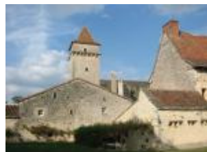
Le château de Couanac : tour érigée au-dessus de la chapelle vue depuis le Sud
