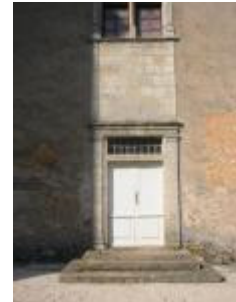
Le château de Couanac : le portail d'entrée de l'aile nord
