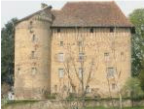
Le château de Puy-Launay : la façade est du corps de logis principal
