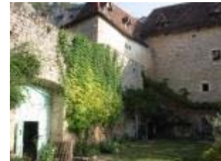
Le château de Geniez : la courtine, le portail d'entrée et le corps de logis est
