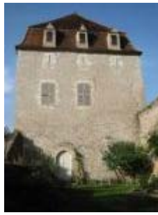
Le château de Geniez : la façade sur cour du logis ouest
