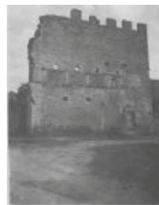
Le château : la façade nord
