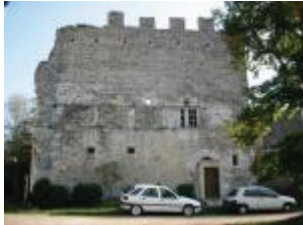
Le château : la façade nord
