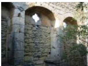
Le château : embrasures des fenêtres géminées et leurs coussièges en pierre sur le revers de la façade nord
