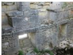
Le château : jours éclairant les pièces du rez-de-chaussée et coussièges des fenêtres de l'étage, vus depuis le revers de la façade nord
