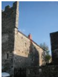
Le château : la façade latérale ouest
