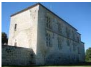
Le château : l'élévation sud et la façade arrière est
