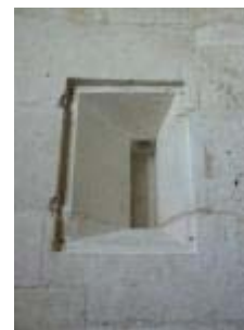
Le château : niche d'éclairage pour bougie dans l'escalier en vis
