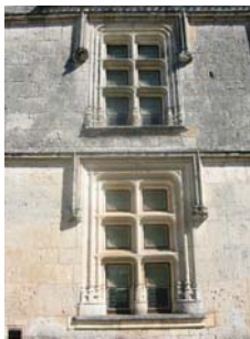
La façade principale ouest
