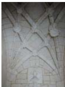
Le château : la voûte à liernes et tiercerons du vestibule
