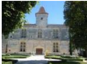
Le château : la façade ouest
