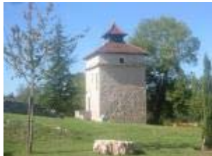
Le pigeonnier garde piles du château
