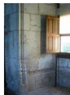
Le château : bases prismatiques sculptées dans une des embrasures des fenêtres croisées de la grande pièce du rez-de-chaussée
