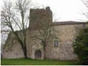
Le château de Marcilhac : la façade nord
