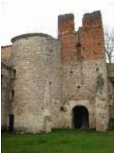
Le château de Marcilhac : la tour ronde et la tour d'entrée vues depuis la cour intérieure
