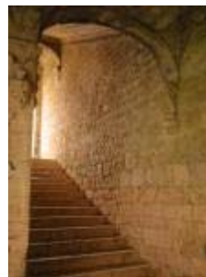
Le château de Marcilhac : première volée de l'escalier droit
