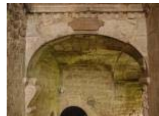
Le château de Marcilhac : couvrement de la première volée de l'escalier droit
