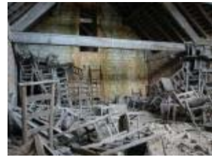
L'église Saint-Hilaire : combles au-dessus de la nef
