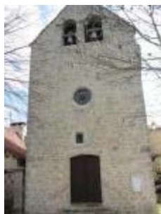
L'église Saint-Hilaire : la façade ouest
