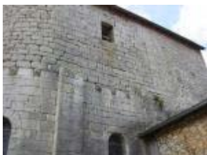
L'église Saint-Hilaire : côté nord de la chambre forte
