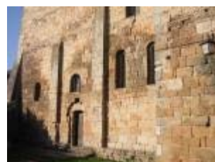
L'église Saint-Pierre-ès-Liens : l'élévation sud épaulée par des contreforts plats
