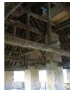
L'église Saint-Pierre-ès-Liens : la charpente
