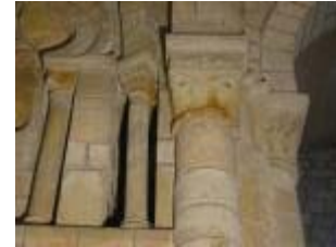
L'église Saint-Pierre-ès-Liens : chapiteaux sur le mur sud de la travée de chœur
