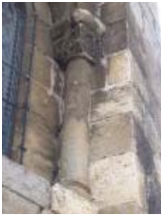
L'église Saint-Pierre-ès-Liens : chapiteau orné de palmettes dans la fenêtre sud-est du chevet
