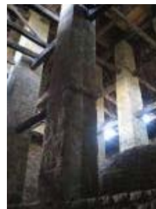
L'église Saint-Pierre-ès-Liens : vue intérieure de l'étage fortifié
