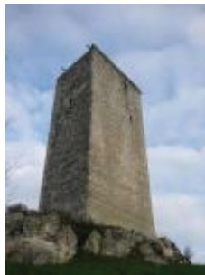
La tour : l'élévation nord-ouest de la tour
