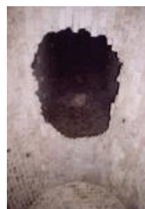
La tour : la voûte du premier étage
