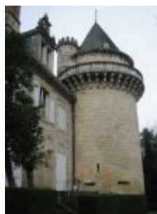
Le château de Crozes : la tour circulaire nord-est
