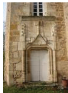
Le château de Crozes : le portail d'entrée de la tour d'escalier
