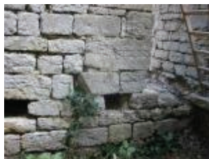
La "tour de péage" : logements de solives portant la galerie de l'escalier extérieur au premier étage de la façade est
