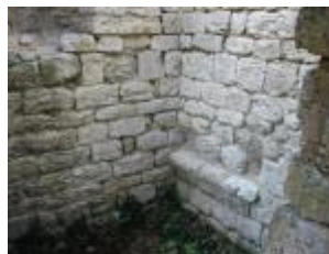
La "tour de péage" : cordon en pierre recevant les solives du plancher dans l'angle nord-ouest au premier étage de la façade est
