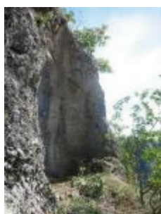
La "tour de péage" : loge taillée dans le rocher, sur la face ouest de l'éperon, en contrebas de la tour
