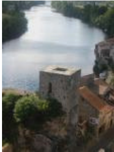
La "tour de péage" : vue de la plateforme depuis le Nord-Est
