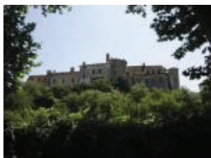
Le château du Bousquet : vue générale depuis le Nord
