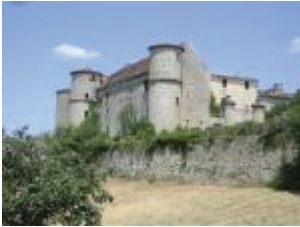
Le château du Bousquet : vue générale depuis l'Ouest
