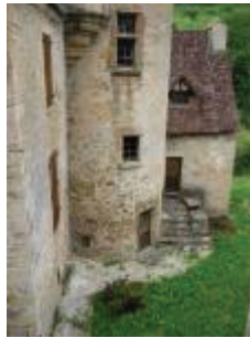
Le château de Limargue : la base de la tour d'escalier, à l'angle des deux corps de logis
