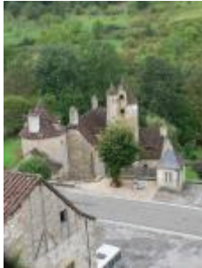
Le château de Limargue : vue générale
