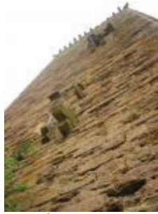
Le château : vestiges de deux latrines sur la façade nord de la tour gothique
