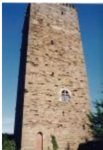
La tour ouest (première moitié 14e siècle)
