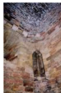
Le château : porte d'accès au troisième niveau de la tour romane
