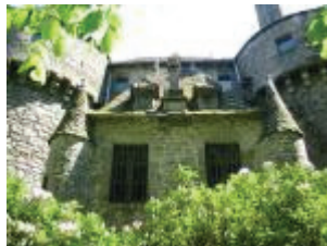
Le château de Grugnac : l'avant-corps logé entre les tours nord-est et nord-ouest
