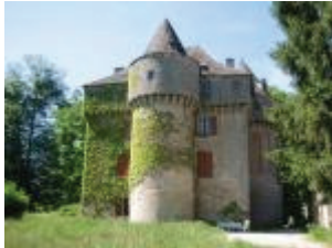
Le château de Grugnac : la façade sud
