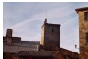
La tour de l'Horloge : vue depuis le nord-est
