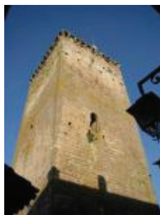
La tour de l'Horloge : élévation sud-est. Une porte au deuxième étage donnait sur une galerie extérieure.
