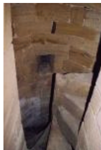
La tour de l'Horloge : escalier en vis reliant le premier au deuxième étage
