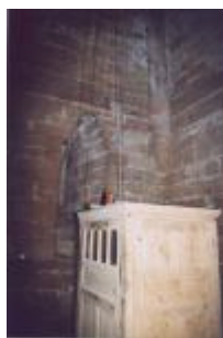
La tour de l'Horloge : latrines en encorbellement sur l'élévation nord-est
