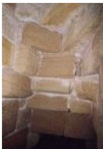
La tour de l'Horloge : voûte sur croisée d'ogives (premier étage)
