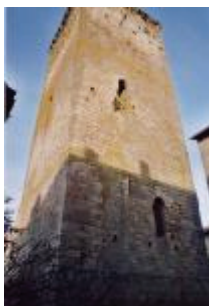
La tour de l'Horloge : élévation sud-est de la tour. La porte du premier niveau s'ouvre à quelques mètres au-dessus du sol extérieur.
