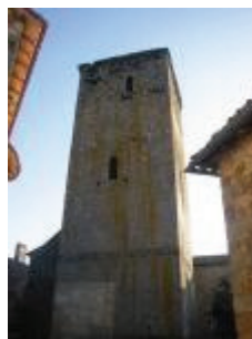
La tour de l'Horloge : la face nord-ouest
