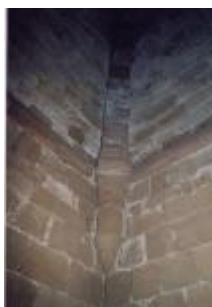
La tour de l'Horloge : la salle du premier étage et la cage de l'escalier semi hors oeuvre
