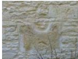
prieuré de grandmontains Notre-Dame, actuellement église paroissiale. Aile orientale, élévation est, détail : linteau délardé en plein-cintre en emploi.
