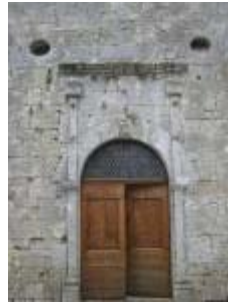
L'église Sainte-Madelaine : le portail ouest percé en 1802 dans la tour romane
