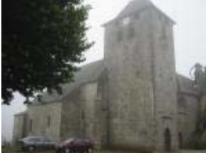
L'église Sainte-Madeleine : vue générale depuis le Nord-Ouest
