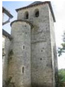
L'église Saint-Pierre-ès-Liens : la tourelle en vis collée contre le clocher et la nef romane
