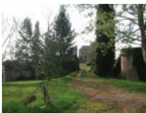
Le château du Théron : l'entrée nord précédée d'un fossé
