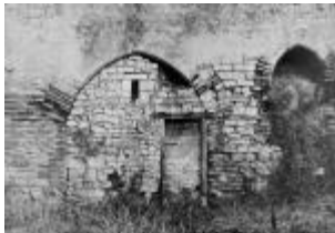
Le couvent : baies du rez-de-chaussée de la salle capitulaire
