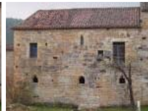
Le couvent : la façade est de la salle capitulaire
