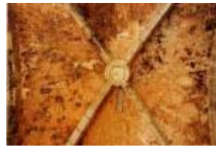
Le couvent : clé de voûte de la travée centrale de la salle capitulaire
