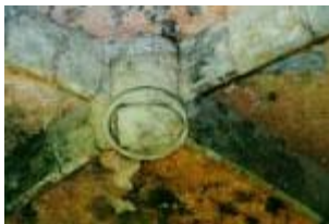
Le couvent : clé de voûte d'une des travées de la salle capitulaire
