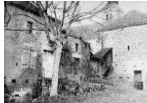
Le couvent : l'aile est vue depuis le Sud-Est (avant restauration)
