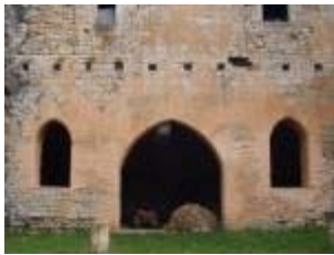
Le couvent : le rez-de-chaussée de la salle capitulaire après restauration (façade ouest)
