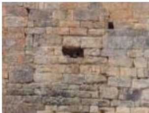
Le couvent : débouché extérieur de l'évier au premier étage sur la façade est de la salle capitulaire
