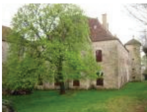
Le château : la façade arrière nord
