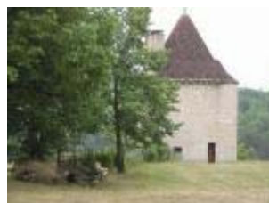
Le château : la tour d'angle sud-ouest de l'enceinte
