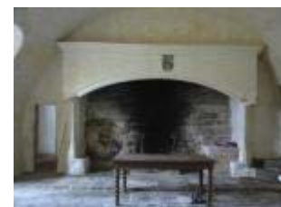
Le château : cheminée de la cuisine au rez-de-chaussée
