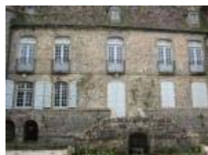
Le château : la façade nord
