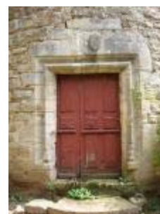
Le château : porte d'entrée de la tour sud
