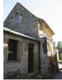
La chapelle Notre-Dame de l'Olm : vue depuis le Sud-Ouest
