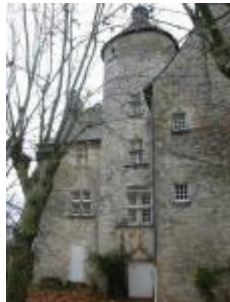
Le château : la tour d'escalier de part et d'autre du bâtiment ouest et du corps de logis nord
