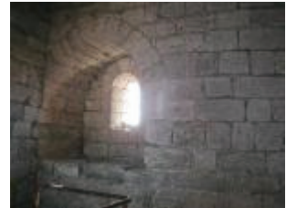
Le château : meurtrière dans le mur ouest de la salle du premier étage
