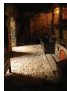
Le moulin de Cougnaguet : sol en pisé de la chambre des meules
