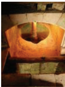
Le moulin de Cougnaguet : l'un des quatre rouets actionnés par le flux dans les cuves
