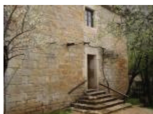
Le moulin de Cougnaguet : porte d'accès à la chambre des meules, ouverte au 19e siècle dans le mur pignon est
