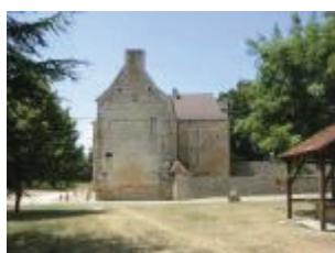
Le château : le mur pignon de l'aile est
