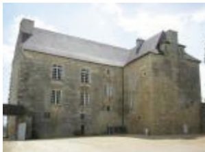
Le château : les façades arrières des deux ailes (côté Nord)
